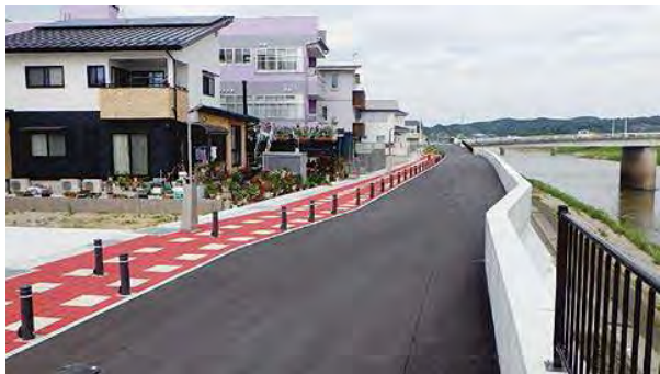
パラペット（特殊堤）整備と本宮市による広場整備
