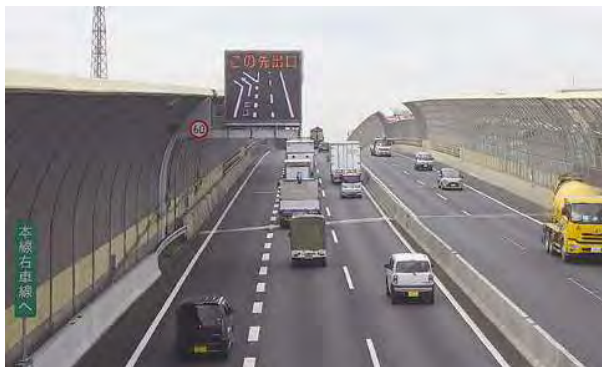
京葉道路 上り 武石～幕張間 付近付加車線設置状況
