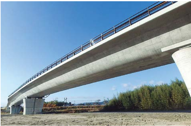
県道広野小高線天神大橋外観
