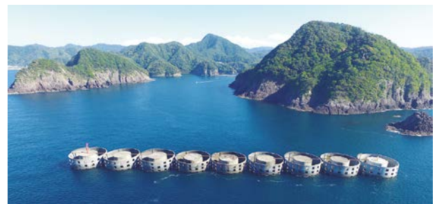
二重円筒ケーソン式防波堤（R2. 5. 29撮影）
