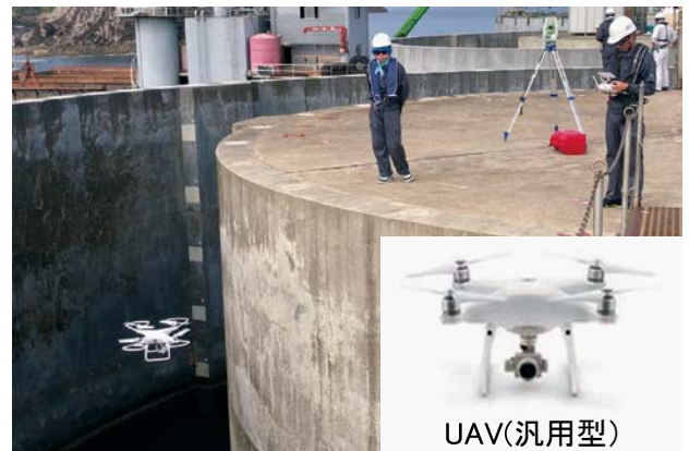
UAVを使用したテスト飛行点検の様子
