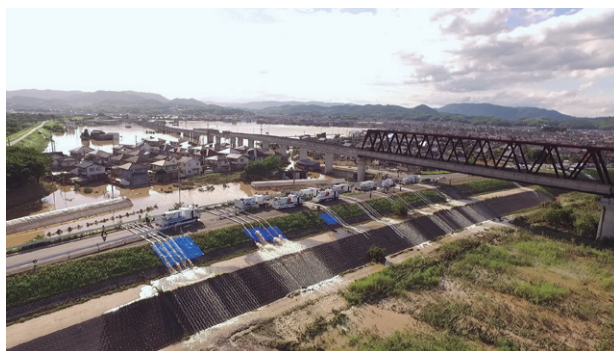
【岡山県倉敷市真備】排水ポンプ車 23 台 24 時間体制で排水
