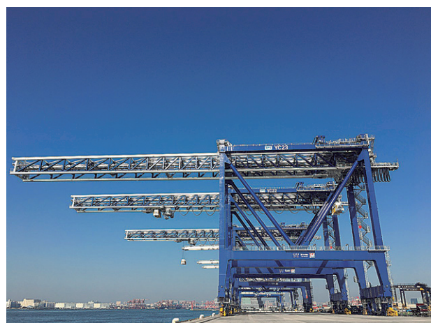
シャトルブーム式ガントリークレーン完成写真
