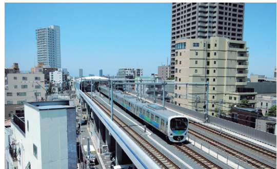
完了状況（石神井公園駅付近）
