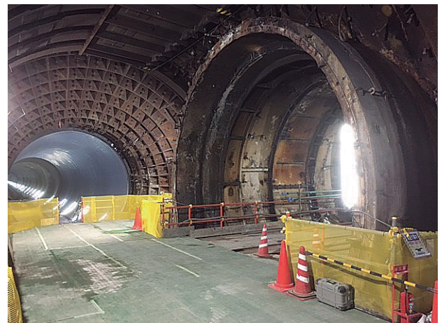
接合完了状況
