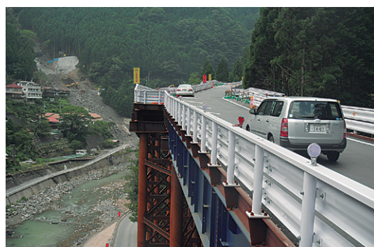
工事用栈橋を利用した迂回路
