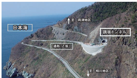
通称「Z坂」中腹に位置する跳坂トンネル
