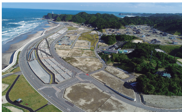
平成 29 年度末に完了した「いわき市平薄磯地区」 (平成 30 年 6 月 ドローン撮影)
