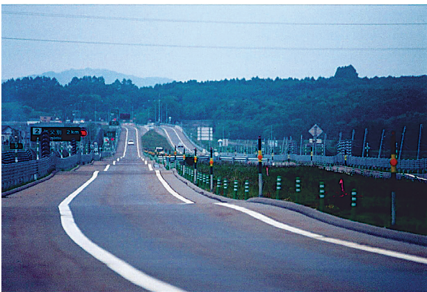
泥炭性軟弱地盤上の道路の不同沈下
