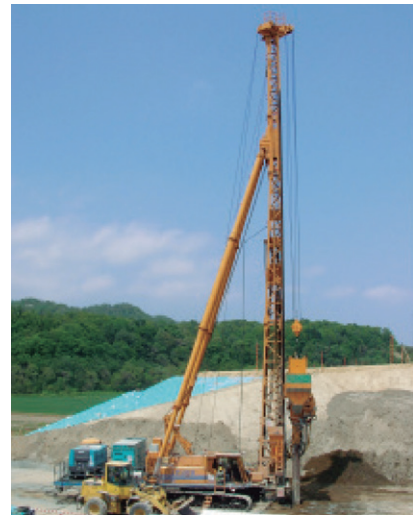
新しい地盤改良技術の施工事例 (グラベルセメントコンパクションパイル工法)
