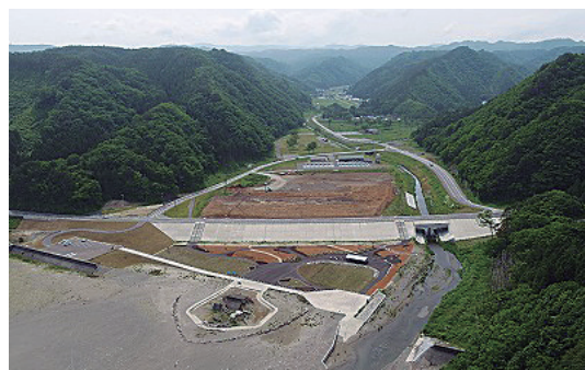
復旧後の防潮堤
