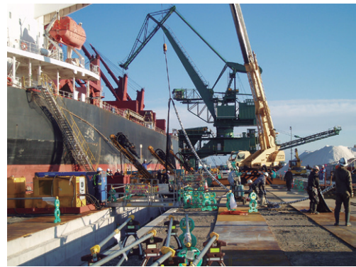
荷役作業とアンカー工施工状況
