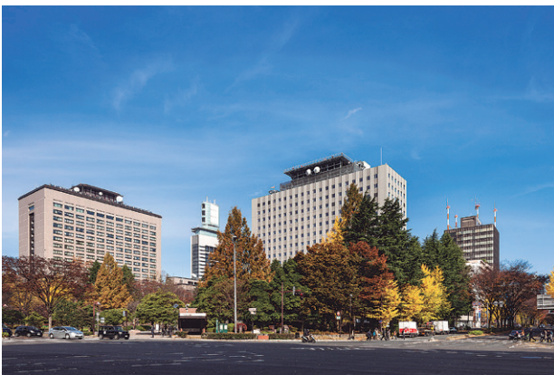
県庁（左）と仙台合同庁舎B棟（右）を望む
