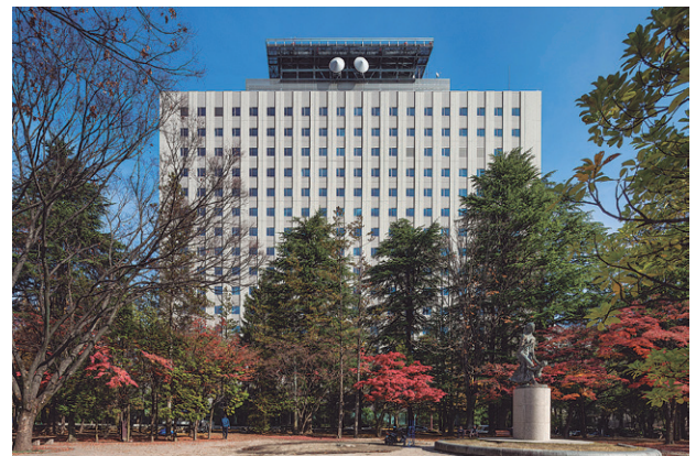
庁舎外観（西側）
