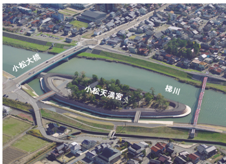
梯川分水路全景
