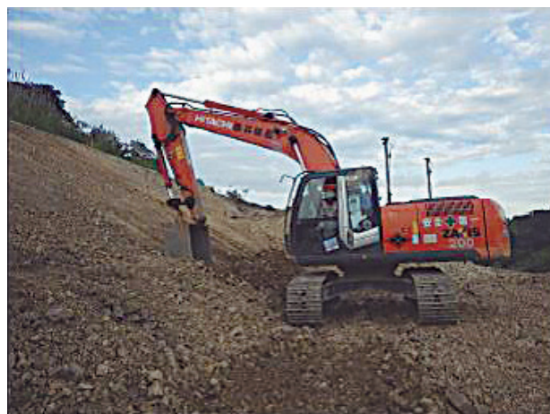
マシンガイダンスを搭載したバックホウによる切土施工
