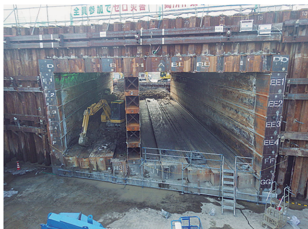
HEP & JES 工法 (鋼製エレメントにて箱型構築後の函体内部掘削状況)
