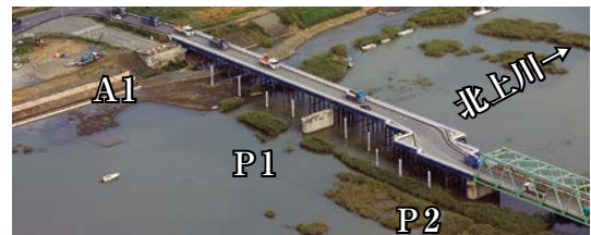
応急仮橋での交通状況
