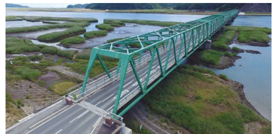
復旧した新北上大橋（左岸上流から望む）
