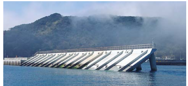
本浦漁港 ジャケット式防波堤
