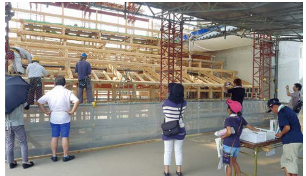
工事見学ステージ（橋爪門）
