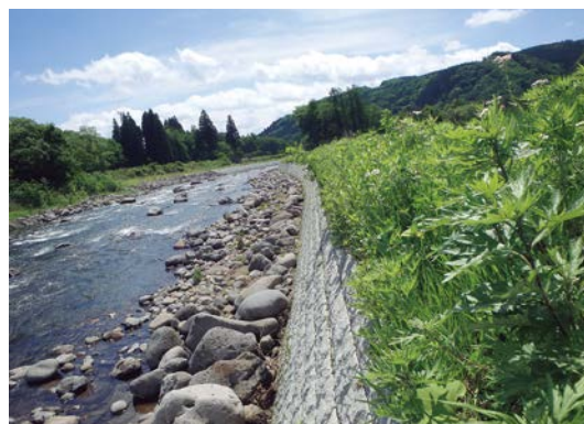
寄せ石と護岸天端覆土による植生回復
