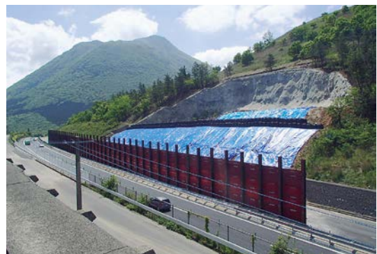
切土のり面 応急復旧状況
