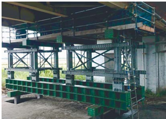
橋梁 応急復旧状況
