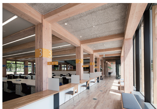
木質ハイブリッド鋼材内蔵型集成材を「柱」と「梁」に活用
