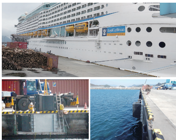
着脱式防舷材（左下：取付作業、右下：設置後）
