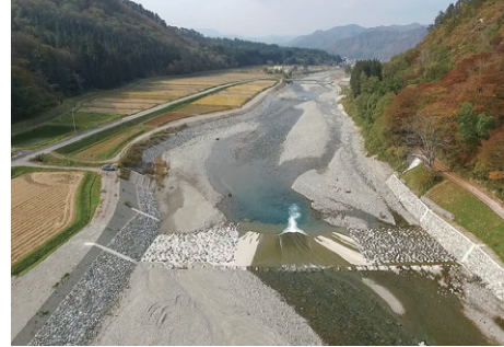
黒谷川 河川災害復旧助成事業
