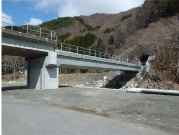
南リアス線、荒川橋りょうの復旧
