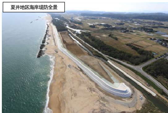
完成した夏井地区海岸堤防
