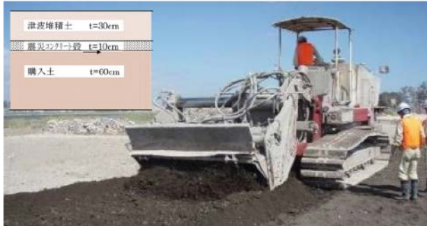
震災がれきの活用 スタビライザー混合状況 津波堆積土 (30%) : コンクリート殻 (10%) : 購入土 (60%)
