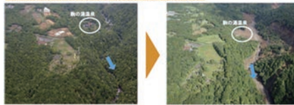
駒の湯温泉被災状況
