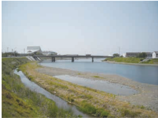
(施工後) 現場発生土の利用による植生の 早期回復及びワンドの保全
