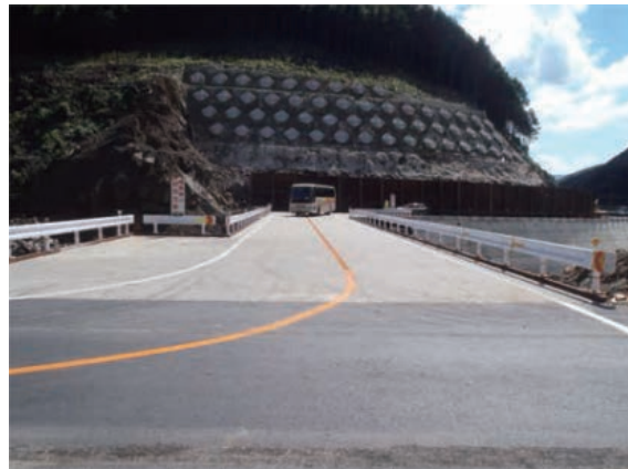
対岸の切土法面を安定させ、 仮橋等で迂回路を設置
