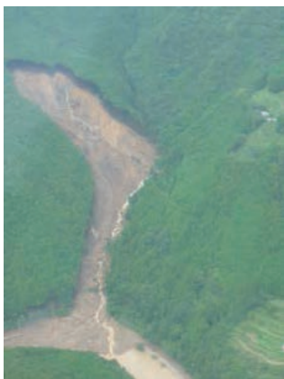
崩壊土砂が国道311号と富田川を覆う
