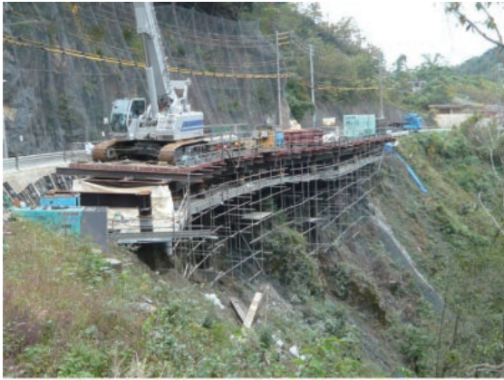
メタルロード工法施工中
