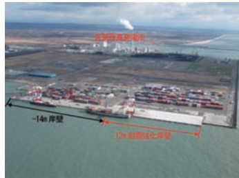
-12m岸壁全景
