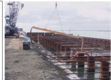
事前混合処理土投入状況
