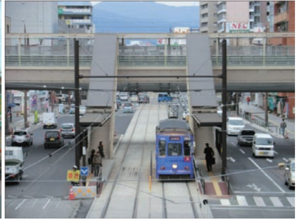
施工後(結節部)
