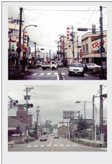
整備前の「空港軽海線」
