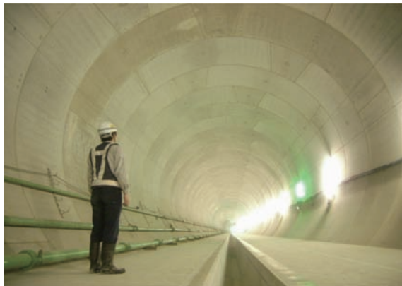
新羽末広幹線（大規模雨水貯留管）の内径6,500mm区間
