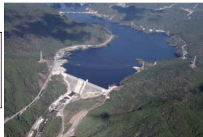
嘉瀬川ダム全景
