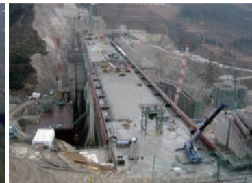
巡航RCD工法全景
