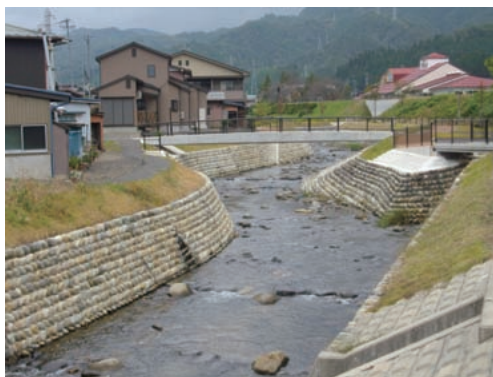
曾部地川河川改修工事
