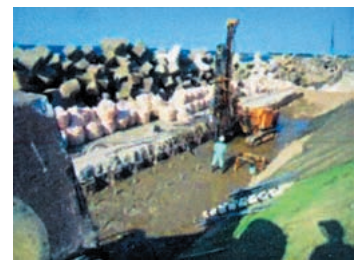
堤防基礎の改良
