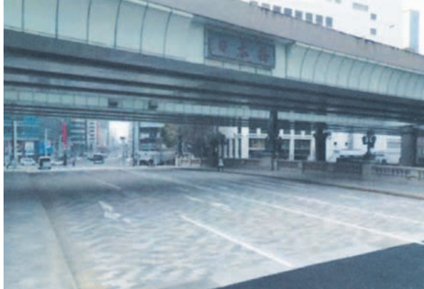
補修が完了した橋面
