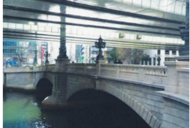
補修が完了した側面
