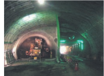
分岐部施工状況
