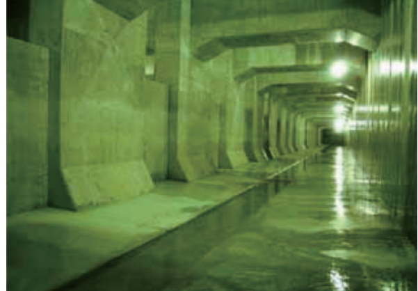
仁和寺調節池完成（内部）
