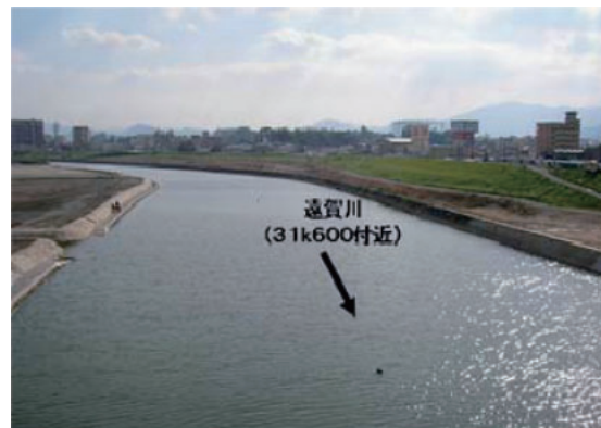
完成した河川状況（河岸掘削＋高水敷盤下げ）
