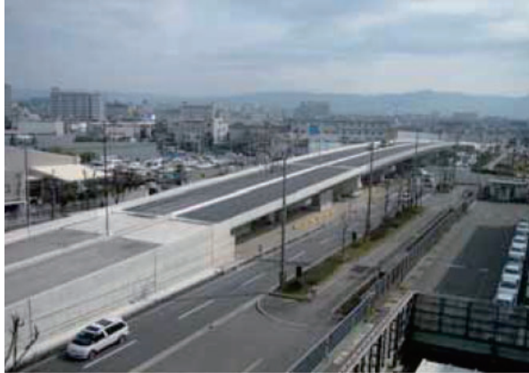
新宝町跨道橋架設完了
