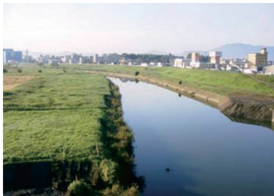
整備前の河川状況
