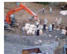
大型土のう設置
