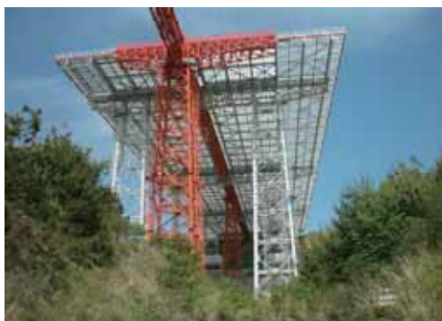
人工地盤 全景
