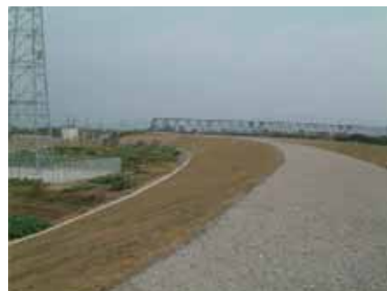
九頭竜川の引提事業（中角地区）の築堤材料活用
