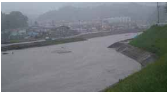
平成18年6月豪雨時、施工中における調節池の貯留効果
