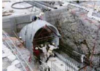
監査廊のプレキャスト埋設型枠
