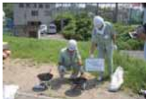
小規模な舗装剥がれ補修
