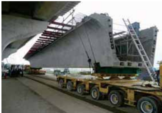
U形プレキャスト桁運搬状況
