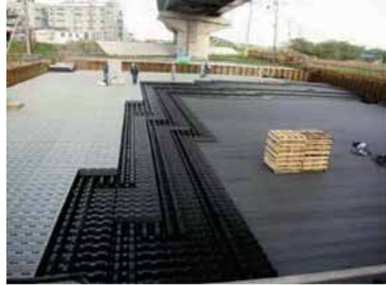
調整池の施工
