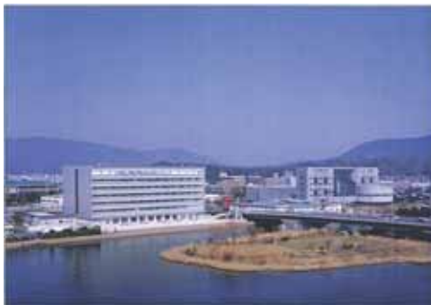
庁舎南西面全景
