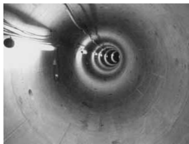
導水路完成断面
