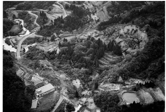
地震直後の河道閉塞状況（10月24日撮影）
