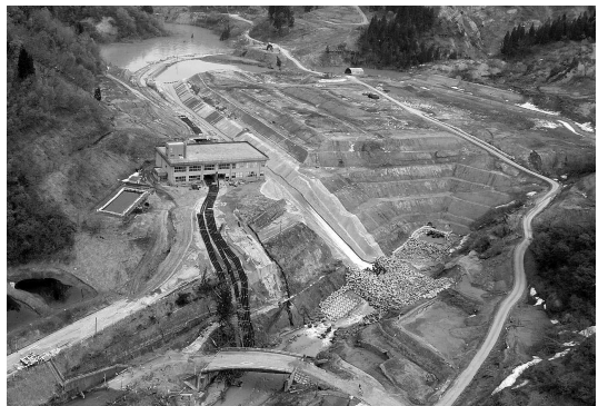
応急対策後の状況。河川水は仮排水路を流下し、元河床に流れている。（5月12日撮影）
